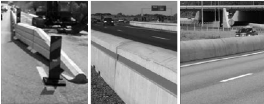
Figur 16 Exempel på betongbärrärer som är godkända i Sverige: Från vänster GP-link, Flex Bloc och S:T Erik (Vägverket, uttryckning, hemsida)
